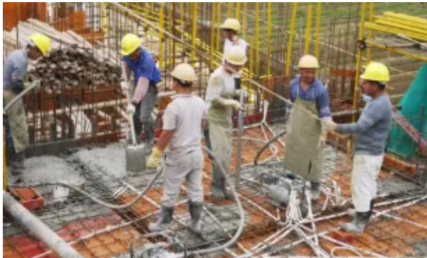
图 1 混凝土浇筑施工
