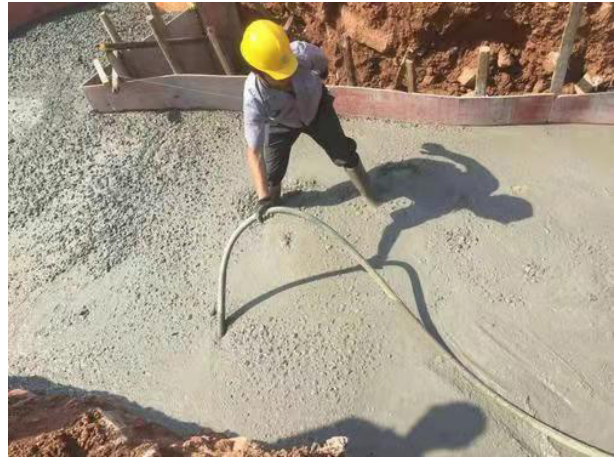
图 2 现场浇筑处理
